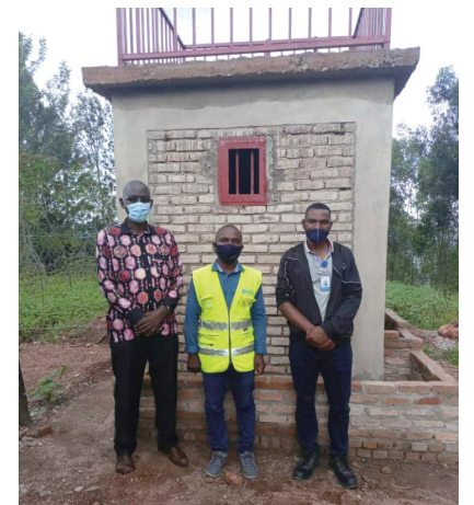
르완다 카모니지역 식수위생사업 수도시설 설치
